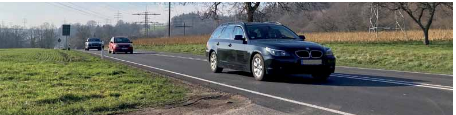
Wo heutzutage die Radroute über die B 34 hinwegführt, verkürzt eine Kuppe die Sicht auf von Westen kommende Kraftfahrzeuge erheblich.
