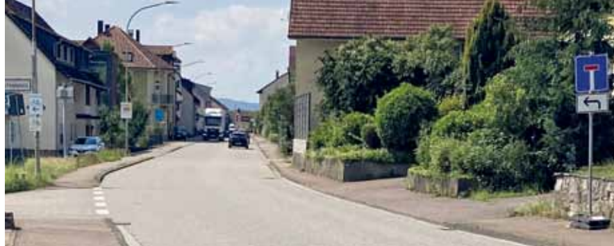
Ein Schild Umleitung Radroute sollte hier auch rechts installiert werden.
