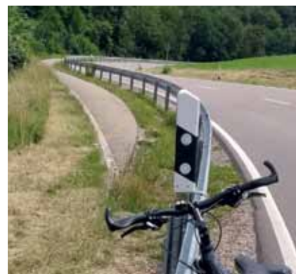
Alter Fahrbahnrest der B 316: vorübergehend nutzbar hinauf zum Waidhof?
