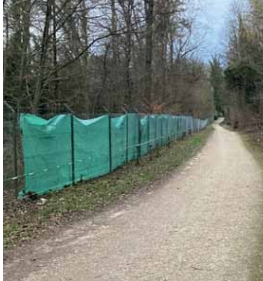
Der Weg über dem Friedhof Hörnli braucht wegen der Pendler eine gut befahrbare Schwarzdecke.
