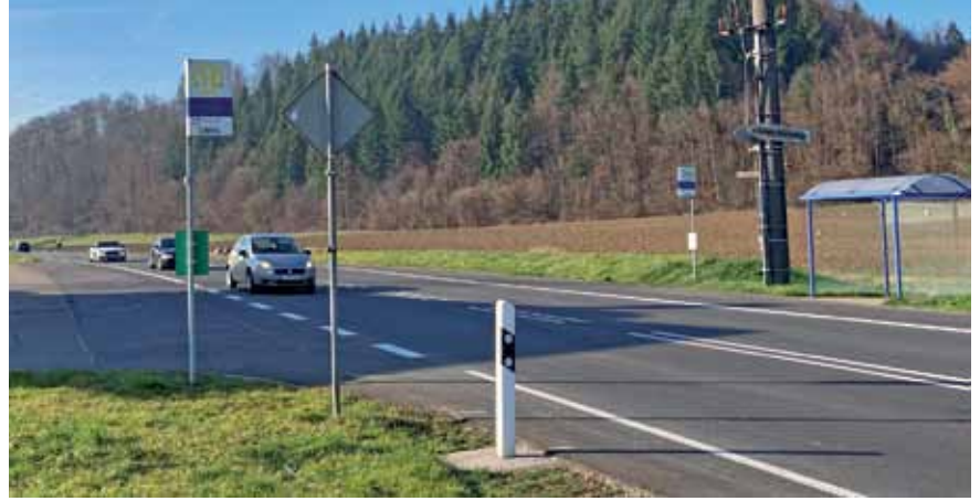
Es gibt immer noch keine sichere Querung der B 34 bei Riedmatt. Die IG Velo Rheinfelden plädiert für eine Lösung hier im Bereich der Einmündung Kraftwerkstraße mit Bushaltestellen auf beiden Seiten der Bundesstraße.
