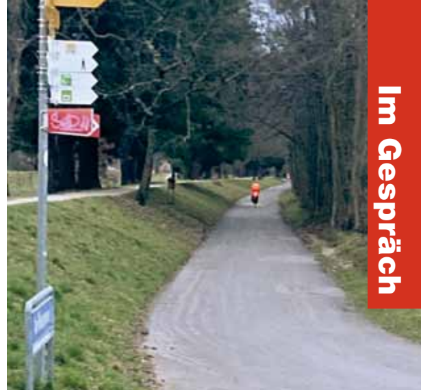
Schmal und schlecht der Belag: 800 Meter Radweg zwischen Weilstraße und Langen Erlen.
