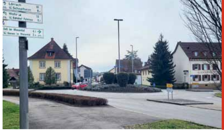
Recht typisch für Mängel in Schopfheim: Am Kreisverkehr Fahrnau werden Radelnde ohne jegliche Führung vom Gehweg in den Mischverkehr entlassen – auch ohne Hinweis für Autofahrer oder Fußgänger.
