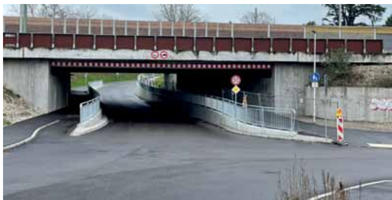
Die westliche Zufahrt zur neuen Unterführung. Als Radfahrer darf man auch an der Seite der Fußgänger unter der Bahn durch – rechts im Bild ist die Auffahrt. Und links, in Gegenrichtung, die Ausfahrt.
