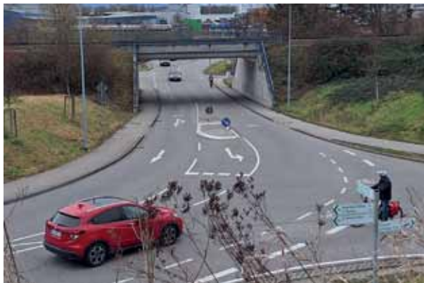
Beim Planen und Bauen der B 34neu in Grenzach-Wyhlen (hier die Bahnunterführung) fand die IG Velo wenig Gehör.
